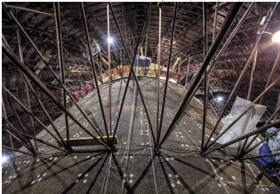
Утепление конического купола в процессе реставрации. 2018 г.
