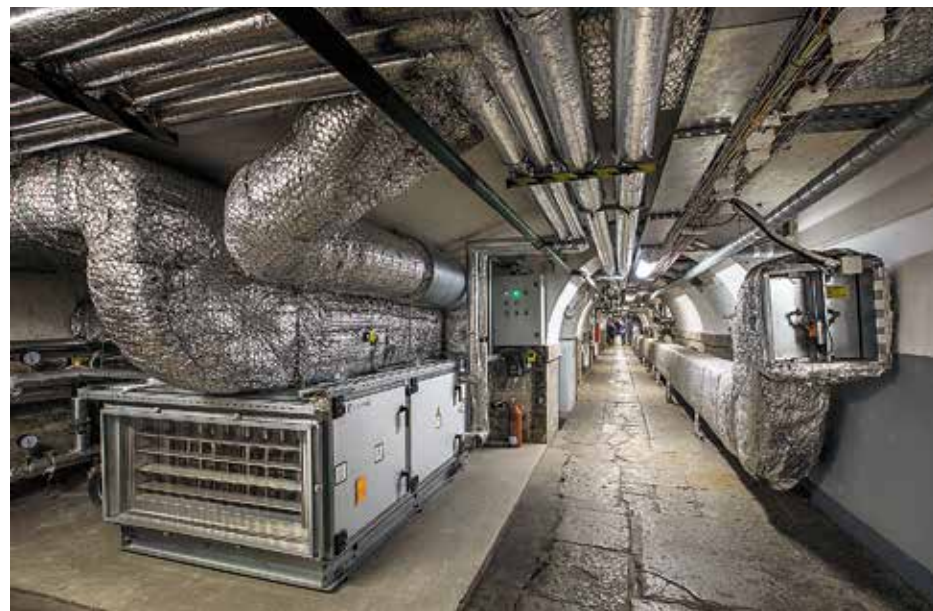
Элементы системы отопления и вентиляции в подвале после ремонта. 2019 г.
