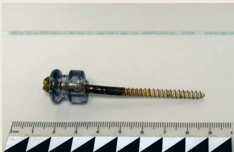
Ил. 5 ▲ Вид на изолятор из зала Виги с оригинальным крепежом
