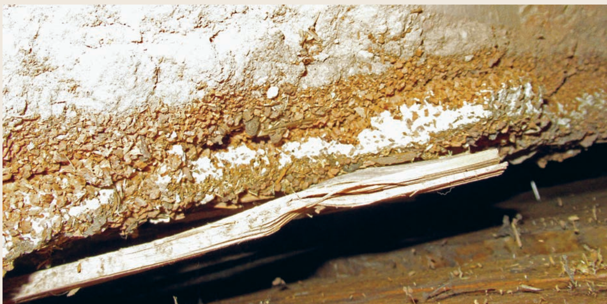
Ил. 9 ▲ Насыпная пробка в перекрытии второго этажа дворового флигеля. Литейный пр., 42. Сама пробка пролита сверху известковым раствором
