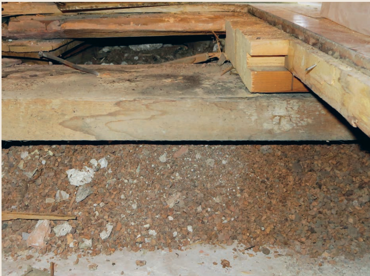
Ил. 8 ▲ Насыпная пробка в перекрытии первого этажа, наб. р. Мойки, 94. Половина молодых
