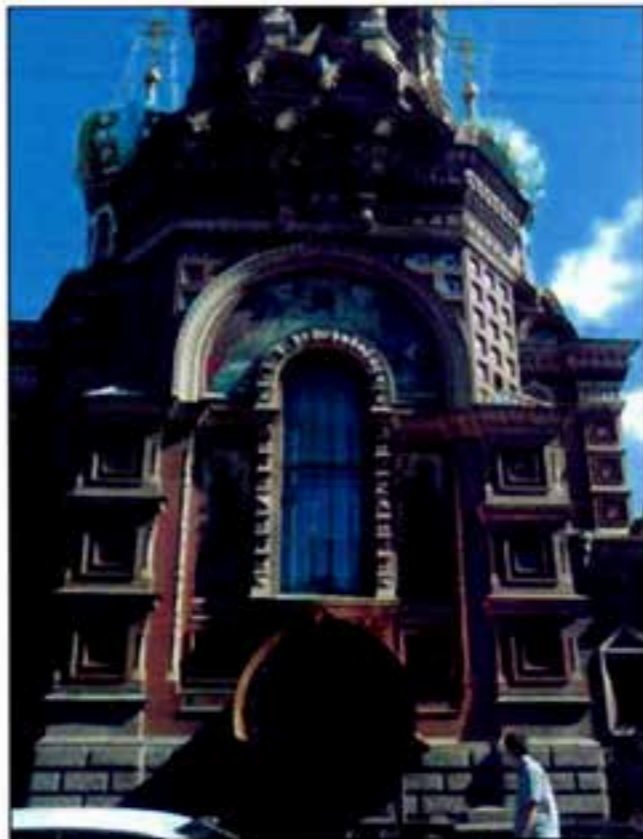
12. «Собор». Западный фасад. Фрагмент.
