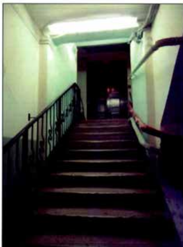
22. Лестница в уровне подвала.
