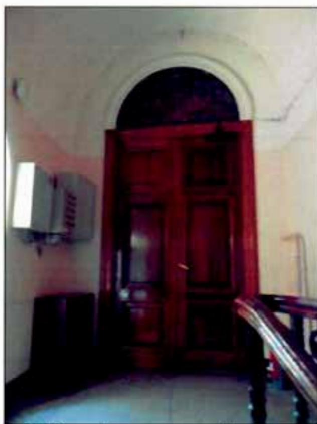
24. Входной проем в уровне 1-го этажа.
