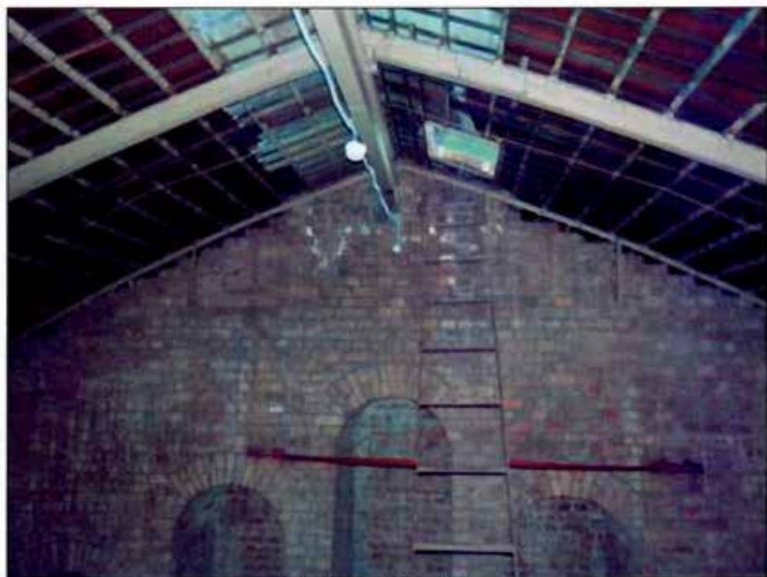
18. Чердак. Общий вид.
