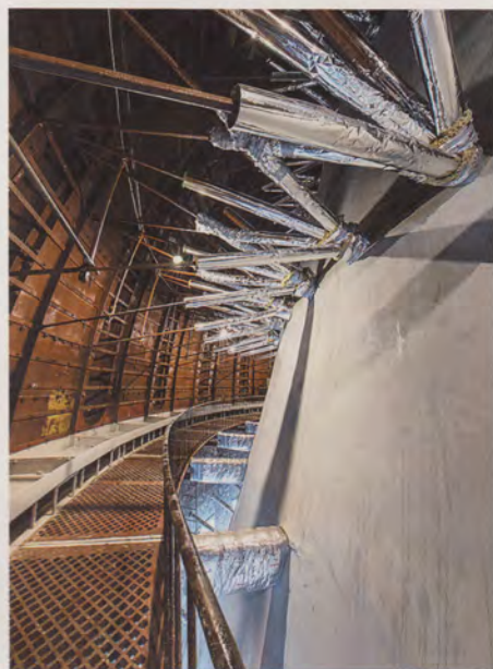
Внутренний конический купол после реставрации. 2019 г.
