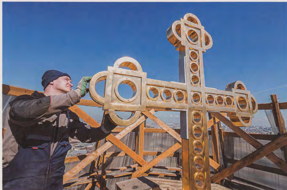
Реставрация венчающего креста. 2016 г.
