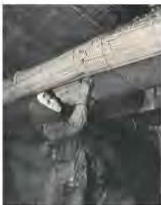
Изготовление теплопровода в подвале собора, 1974 год (© СПб ГБУК «Государственный музей-памятник «Исаакиевский собор», 2023)
