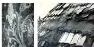
Поврежденные мозаичный блок и черепица на центральном шпире, 1972 год (© СПб ГБУК «Государственный музей-памятник «Исаакиевский собор», 2023)
