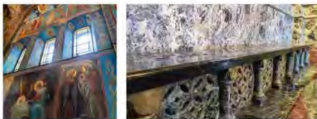
Вентиляционные решетки в подоконниках первого яруса и под скамьями у пола, 2023 год (фото Ирина Кузнецовой)
